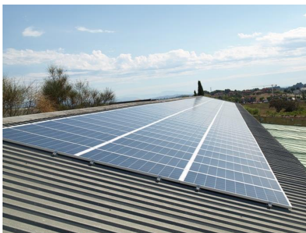
Instal·lació coplanar a coberta de xapa
