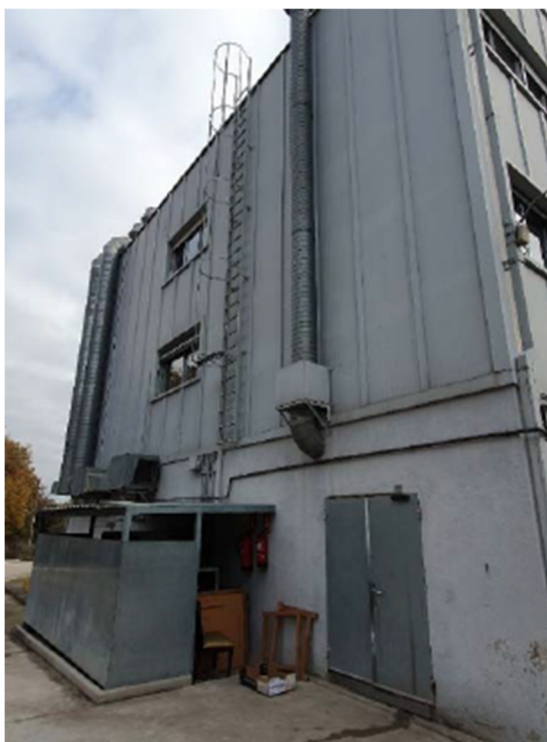
Figura 2. Accés instal·lació zona A
