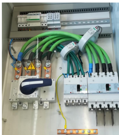
Figura 24. Exemple configuració quadre proteccions CA
