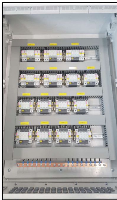
Figura 23. Exemple configuració quadre elèctric proteccions continua
